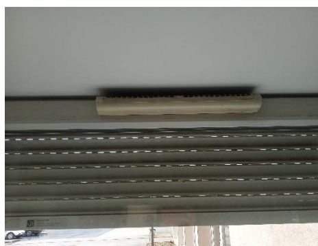
Entrée d'air et volet roulant
