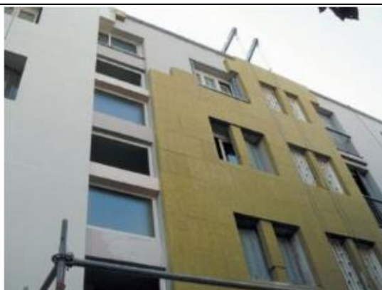
Principe de mise en place d'isolation thermique extérieure
