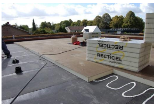
Exemple mise en place d'isolation thermique extérieure en toiture
