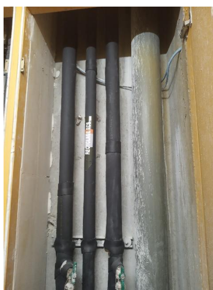
Réseau d'eau chaude sanitaire
