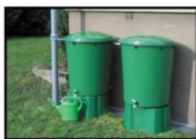
Ballon de récupération d'eau connecté à une gouttière
