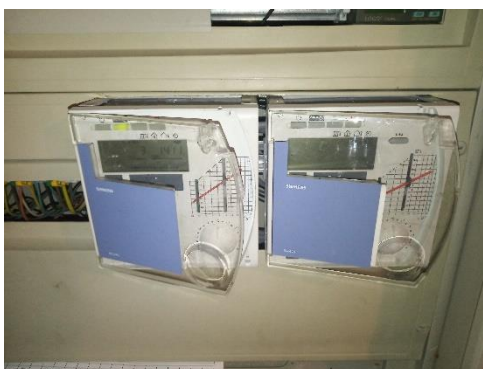
Organe de régulation réseaux chauffage (courbe de chauffe)
