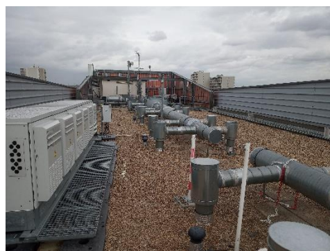
Moteurs de ventilation et réseau d'extraction en toiture
