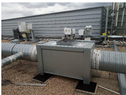
Moteurs de ventilation et réseau d'extraction en toiture
